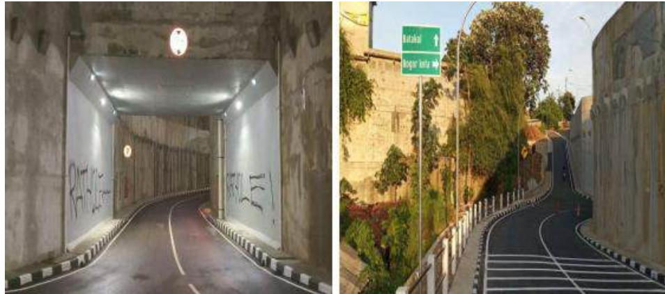
Gambar 3-25 Pembangunan Perlintasan Tidak Sebidang
